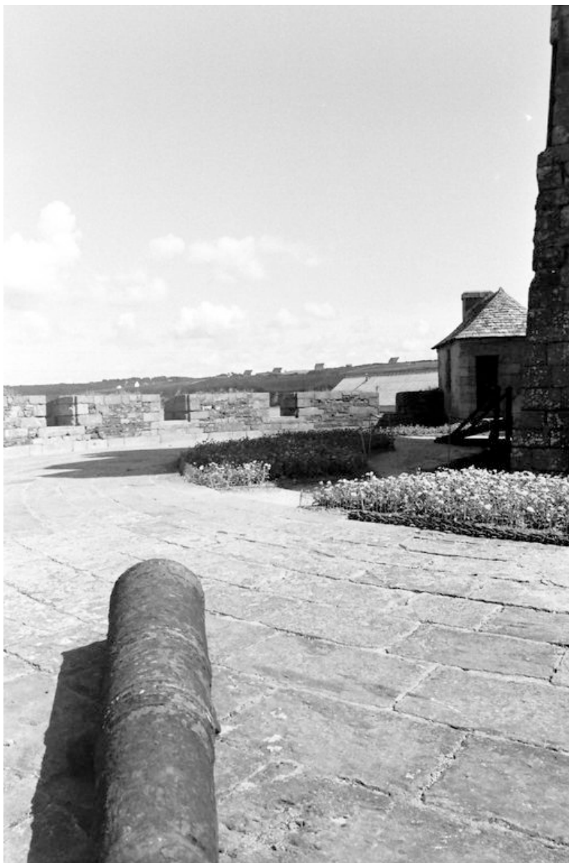
Vue de la tour Vauban en 1967
