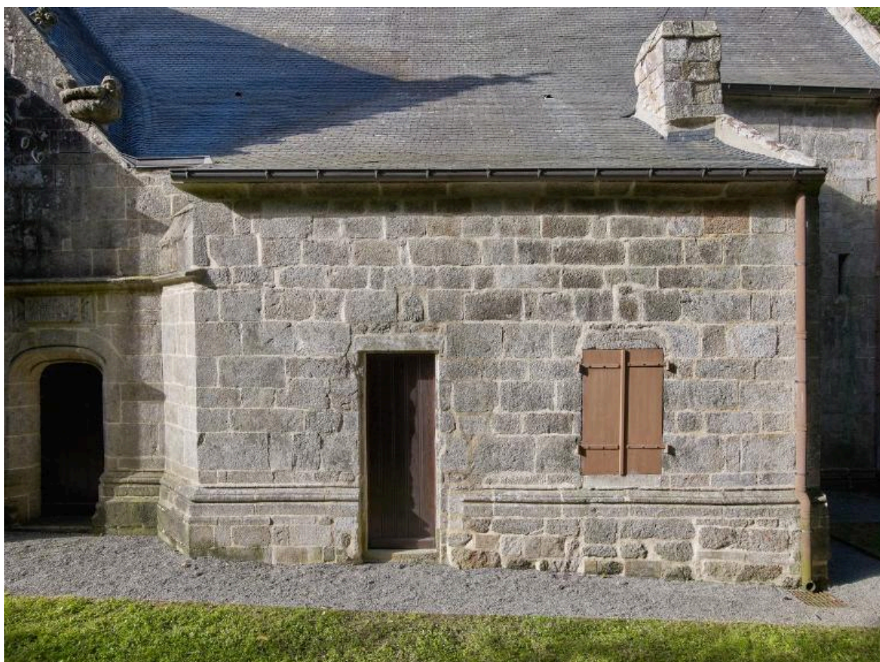
Vue de la sacristie sur la façade nord
