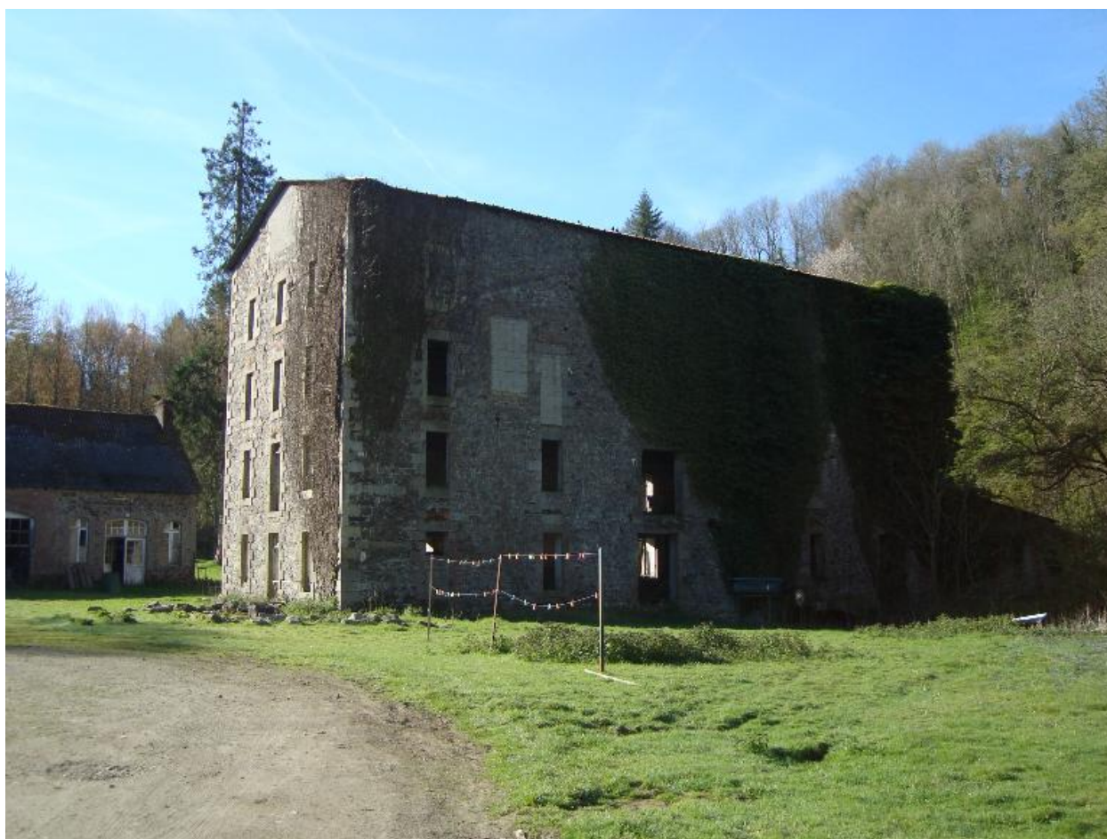
Bâtiment 1 (façade nord oues)
