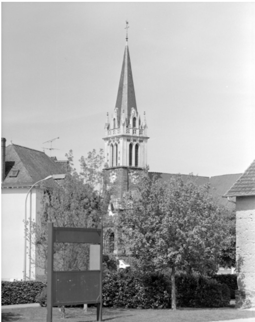
Elévation Sud-Ouest : vue générale
