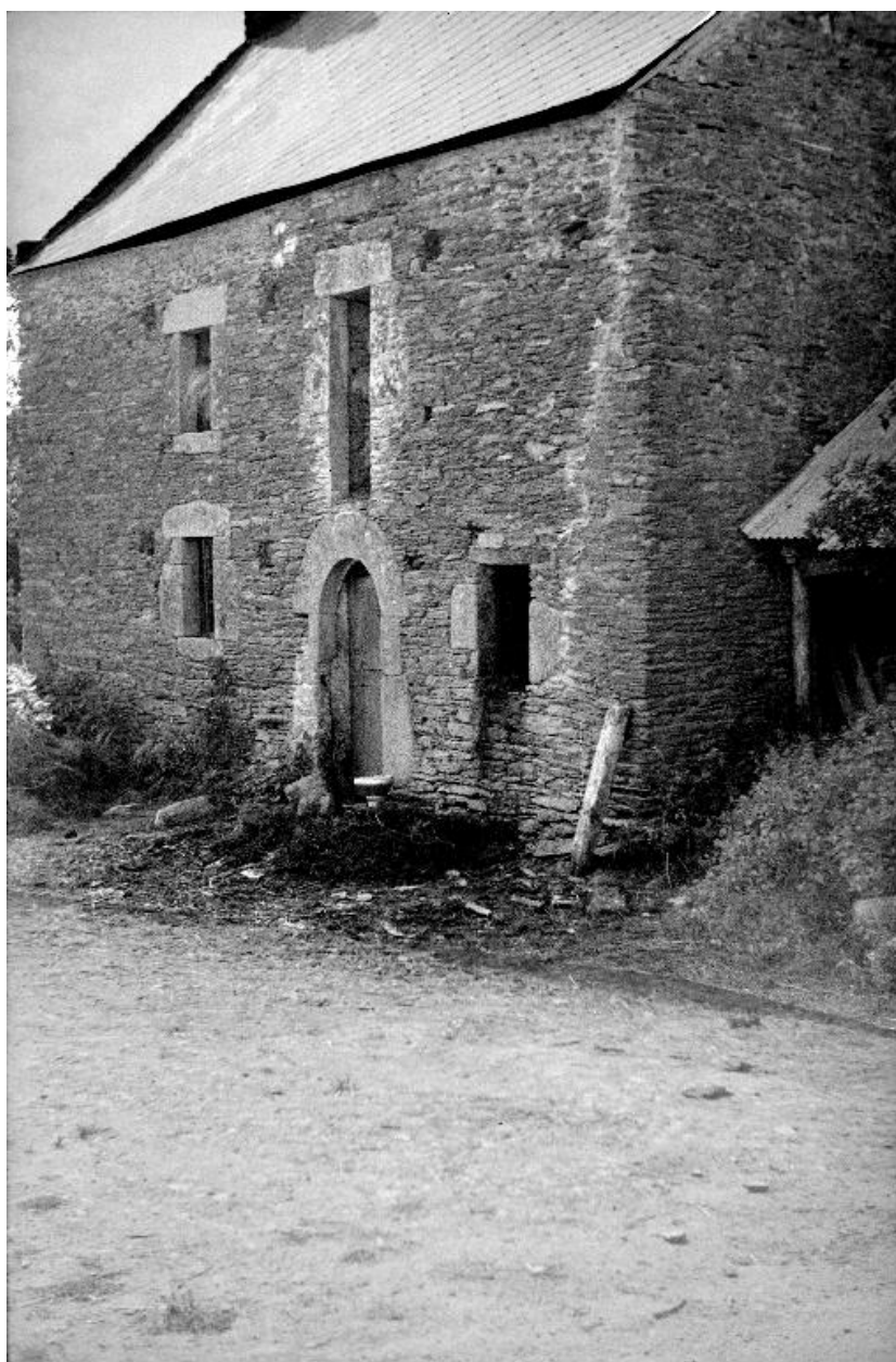
Ferme 16 (état en 1969)
