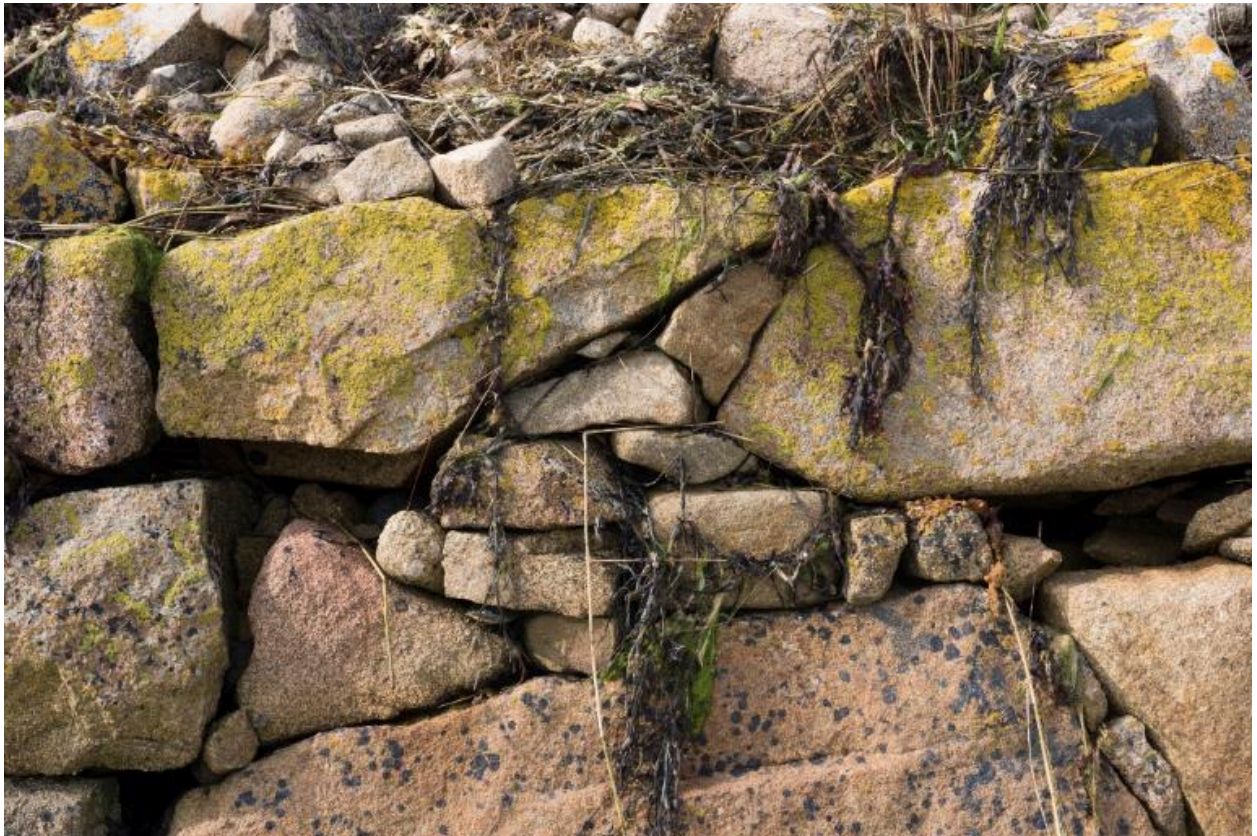
Détail des moellons et des pierres du parement du mur de soutènement au fond de l'anse de Pelinec
