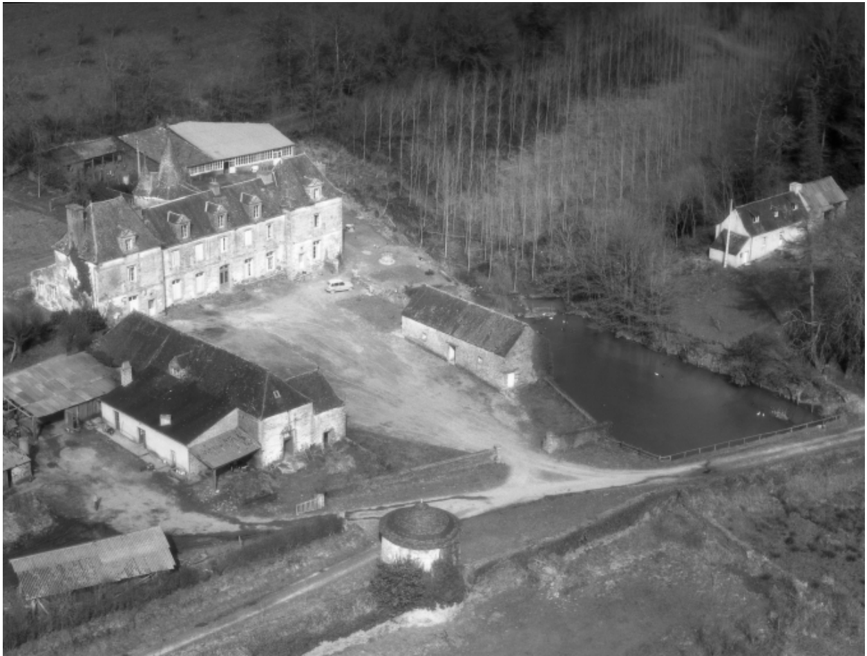
Vue aérienne : vue générale sud-est
