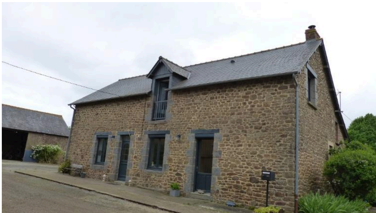
Vue générale sud
