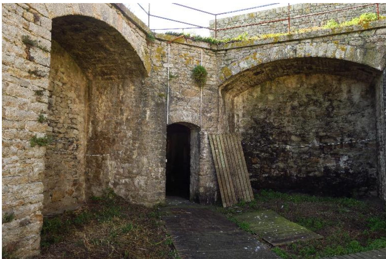
Archipel de Glénan, fort de l'île Cigogne, arcs du chemin de ronde sud-est et accès à la tourelle de latrines.
