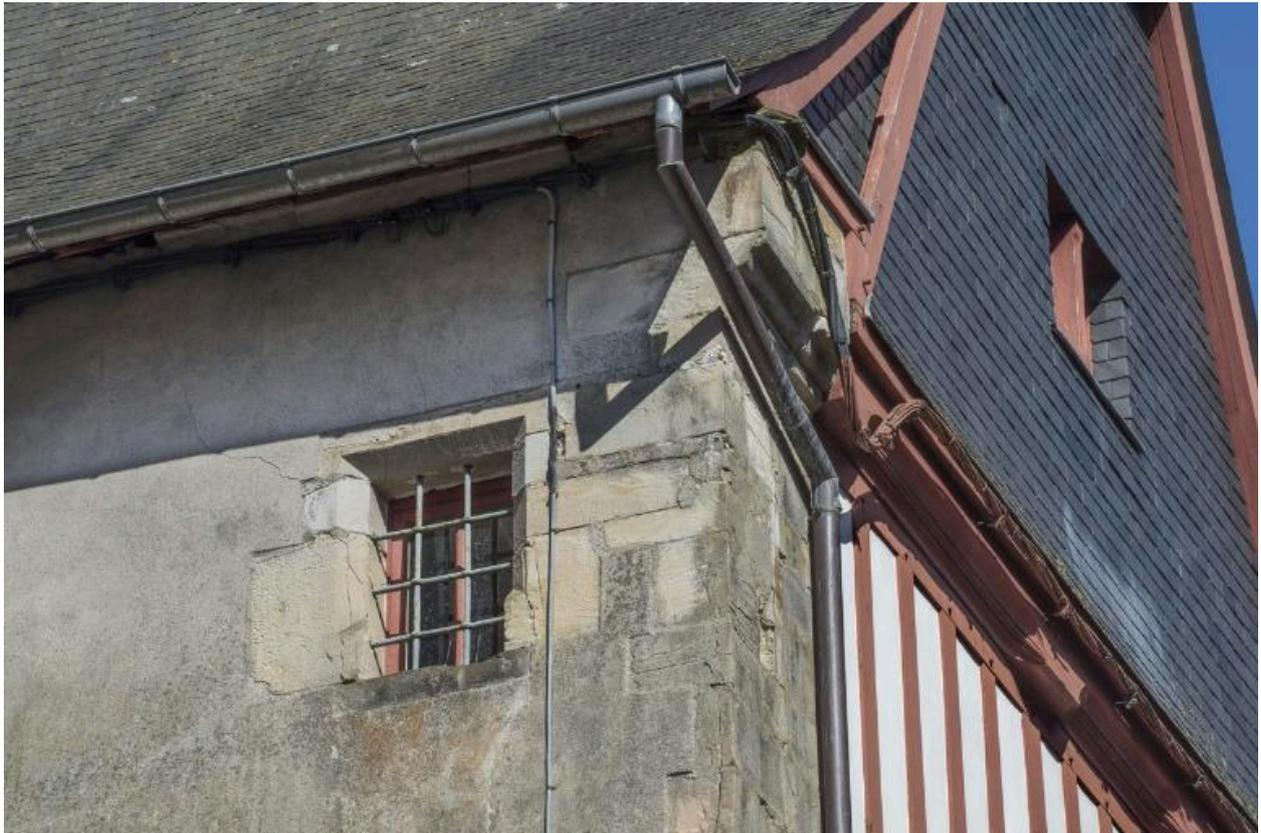
Détail de la gouttière et du deuxième étage de l'édifice. Le pan de bois du pignon est dissimulé sous un essentage d'ardoise.
