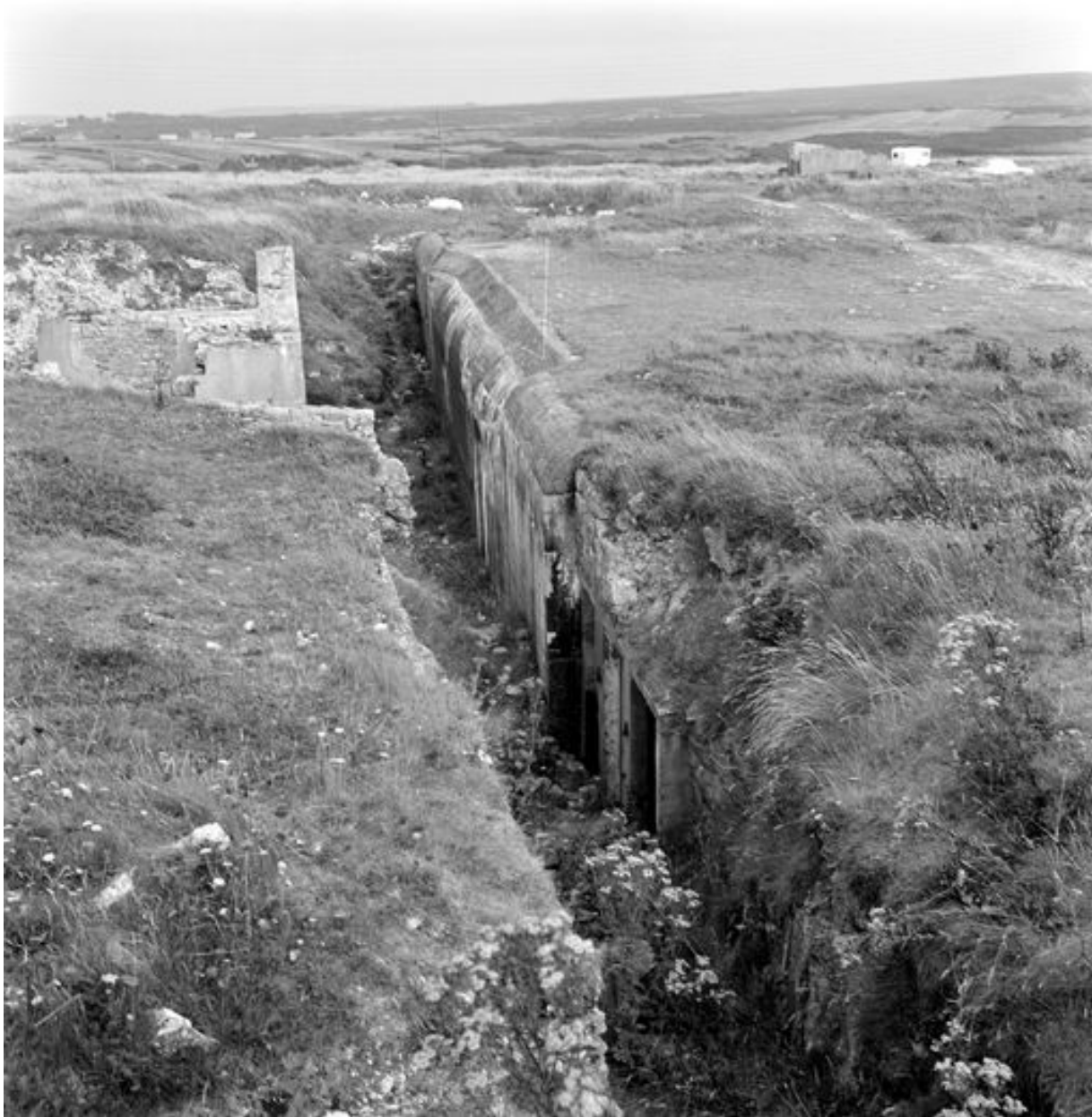
Vue de l'un des bunkers - abris en 1969
