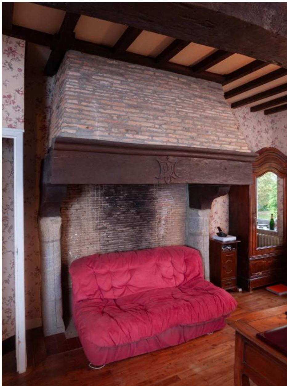
Chambre ou salle haute. Cheminée à jambages en granite, consoles et linteau en bois, contrecœur et hotte en brique
