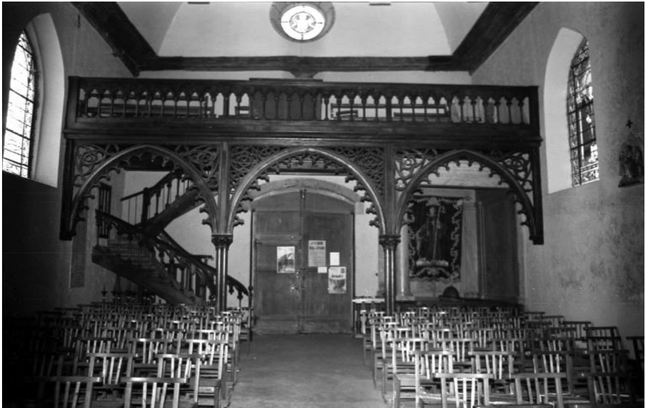
Tribune néo-gothique, vue de la croisée du transept, état en 1972
