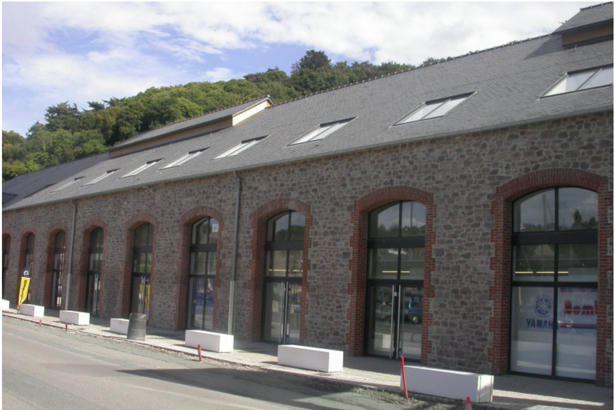
détail de la façade sur rue
