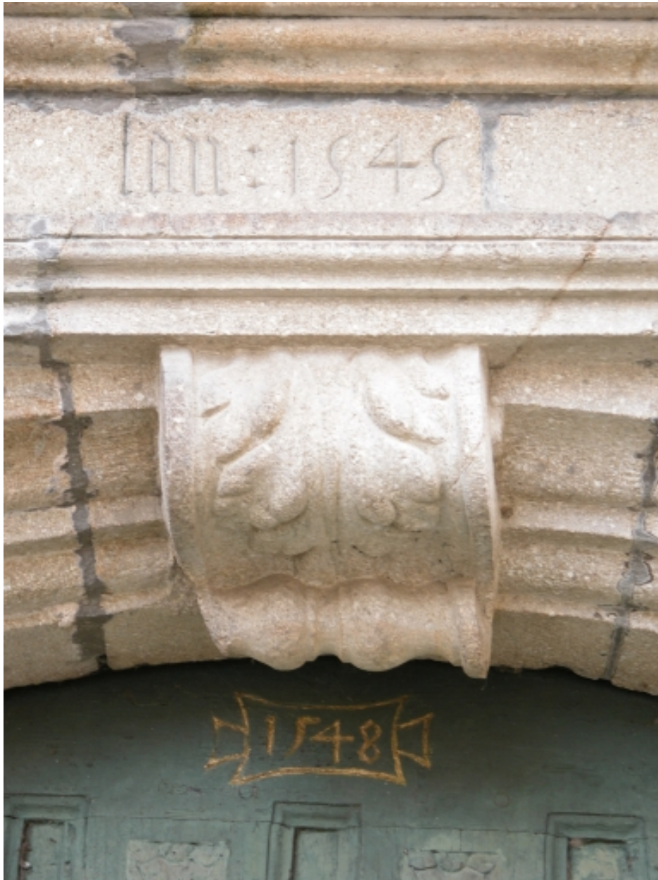
Porte nord ; détail
