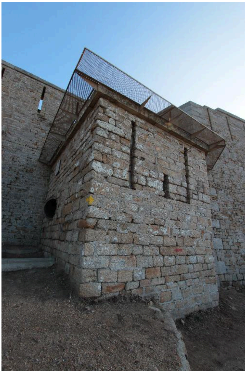
Saint-Pierre-Quiberon, fort de Penthievre, enceinte, poste de communication optique sur l'ancienne poterne du front sud-ouest.
