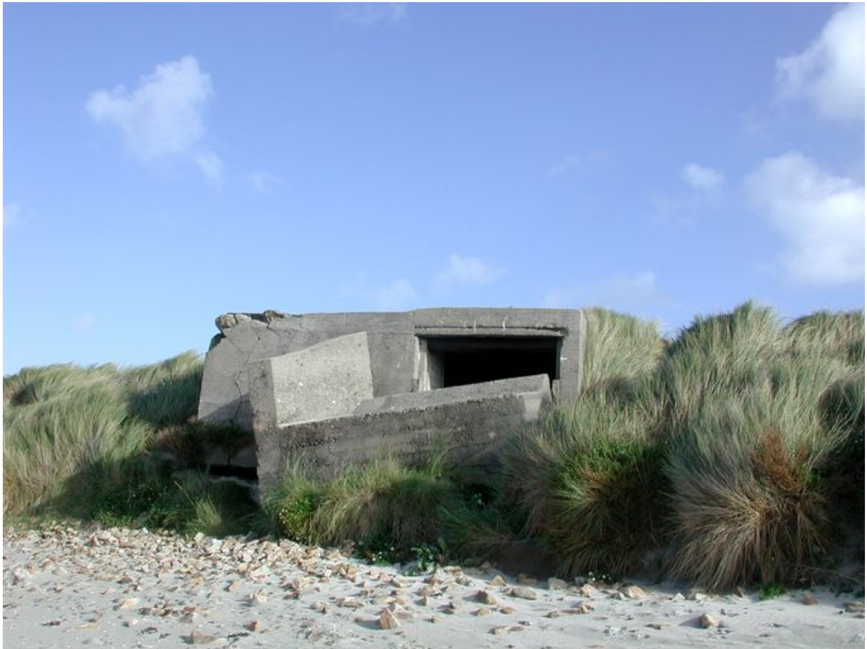
Vue du bunker-casemate pour canon de 5 cm ou 7,5 cm depuis l'ouest (état en 2003)
