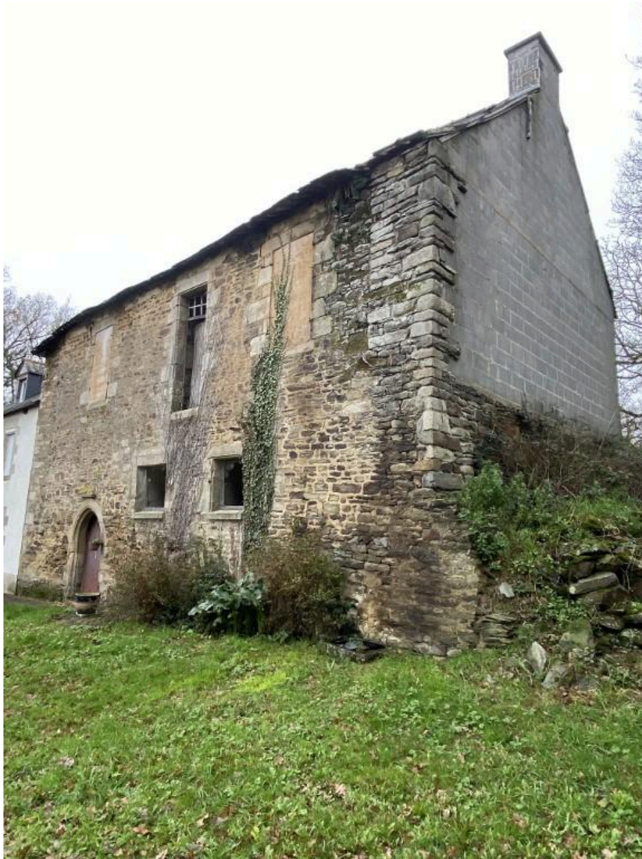
Élévation sud, vue ouest
