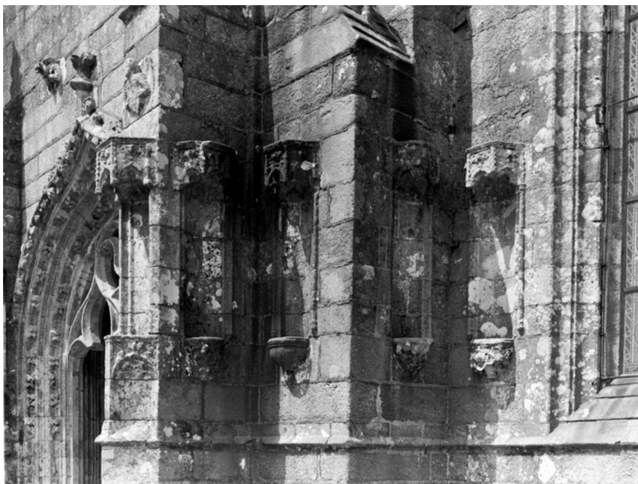
Angle du porche et du bras sud du transept
