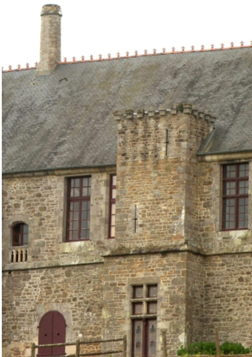
Château, façade donnant sur la Rance, détail
