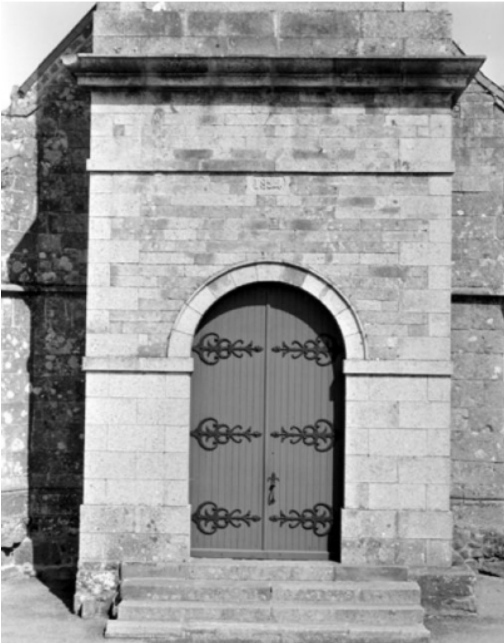
Elévation ouest, porte principale : vue générale
