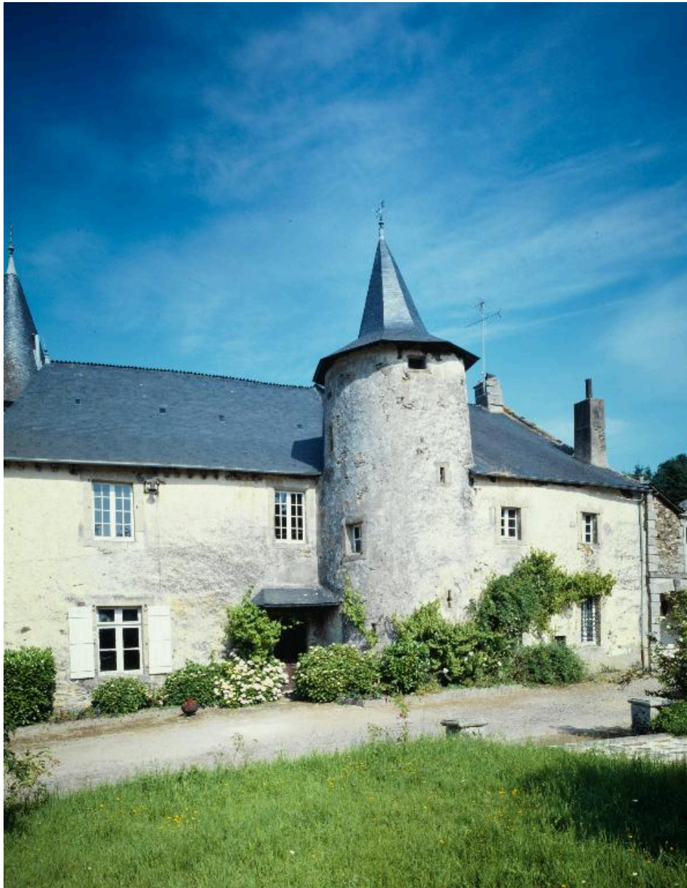
Logis du 17 e siècle : vue générale depuis l'est (état en 1988)
