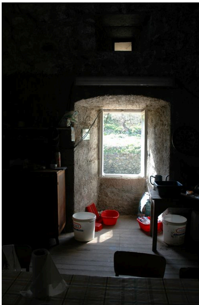
Vue intérieure : premier étage, fenêtre sud (état en 2006)
