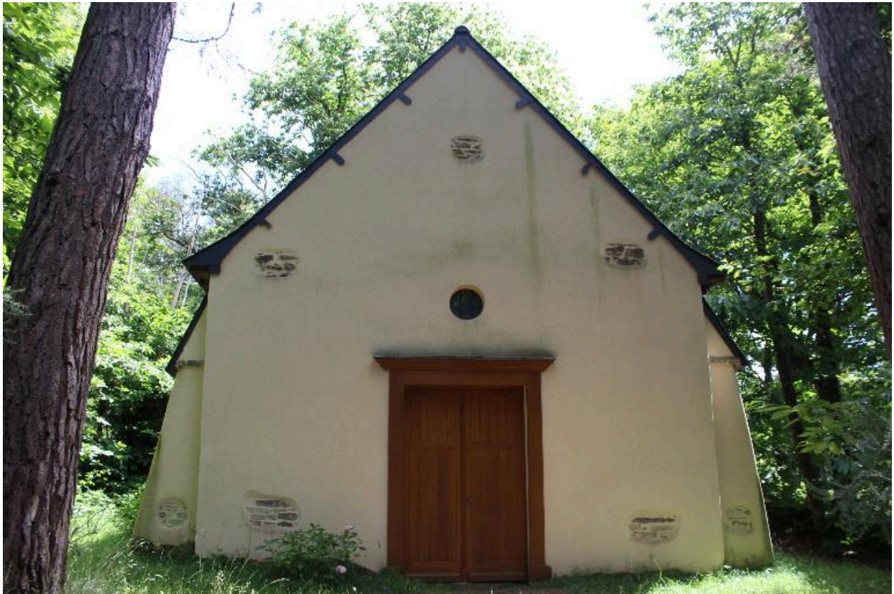
Façade occidentale - Vue générale
