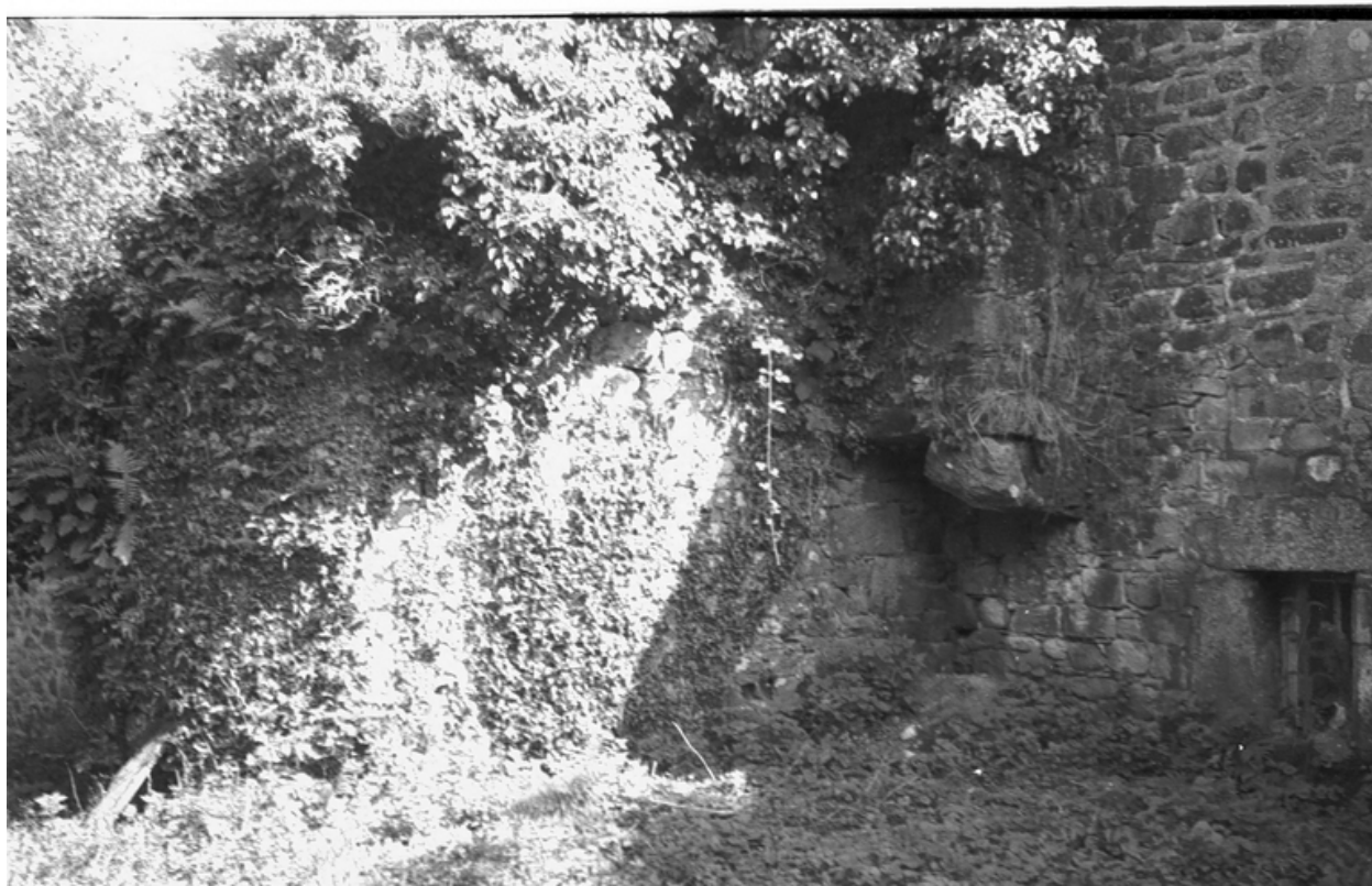
Elévation nord, détail.
