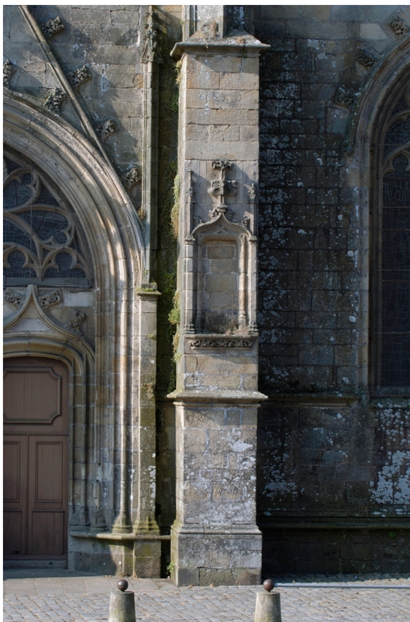
Détail contrefort du portail nord
