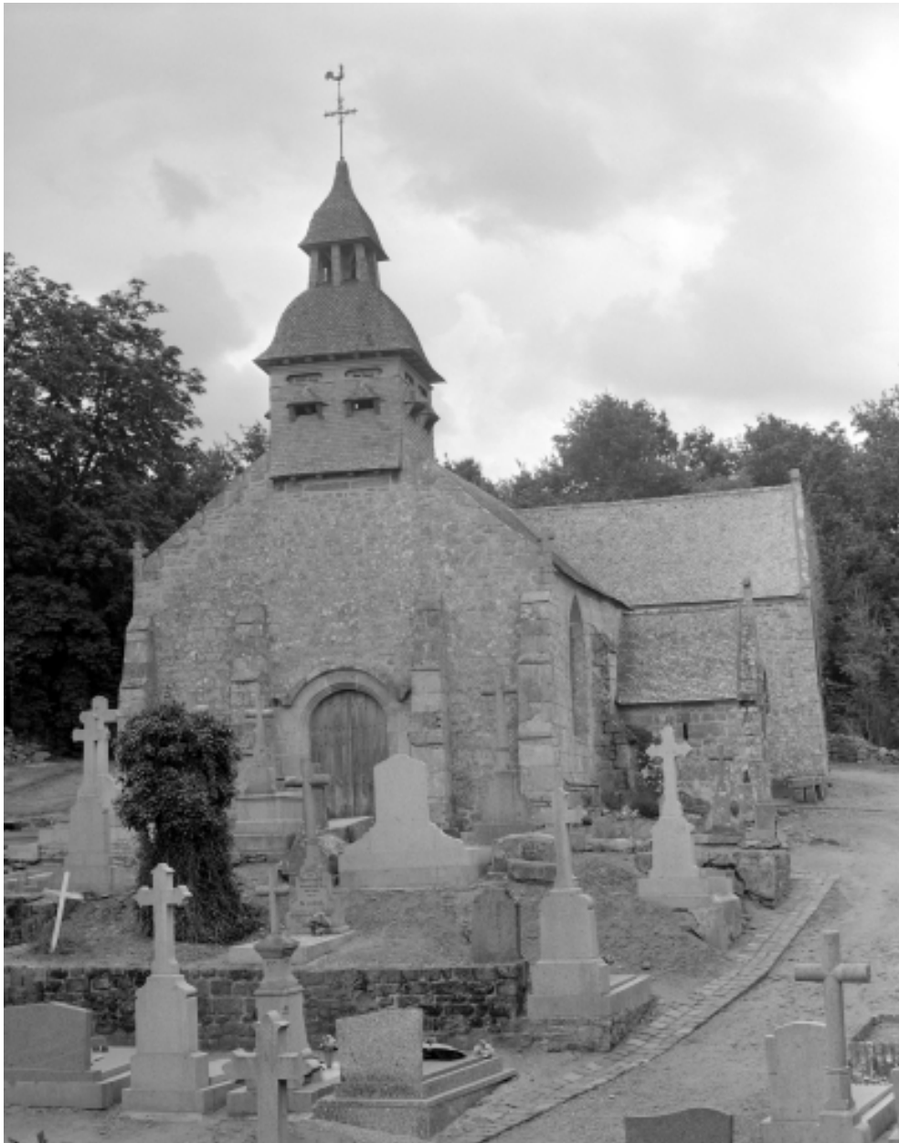
Elévation Ouest : vue générale
