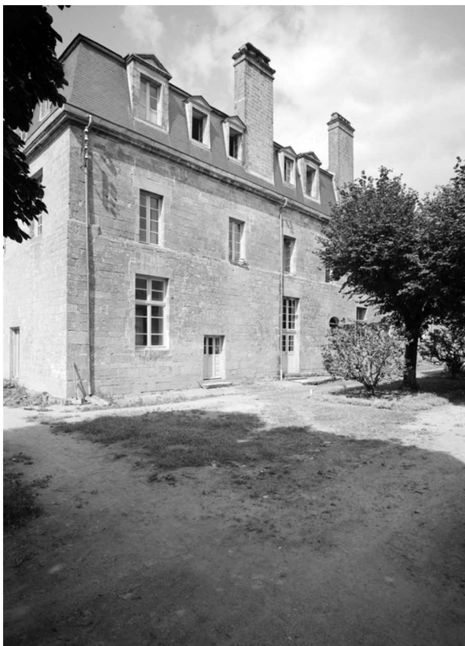
Corps de bâtiment D, façade est, partie sud (1965)
