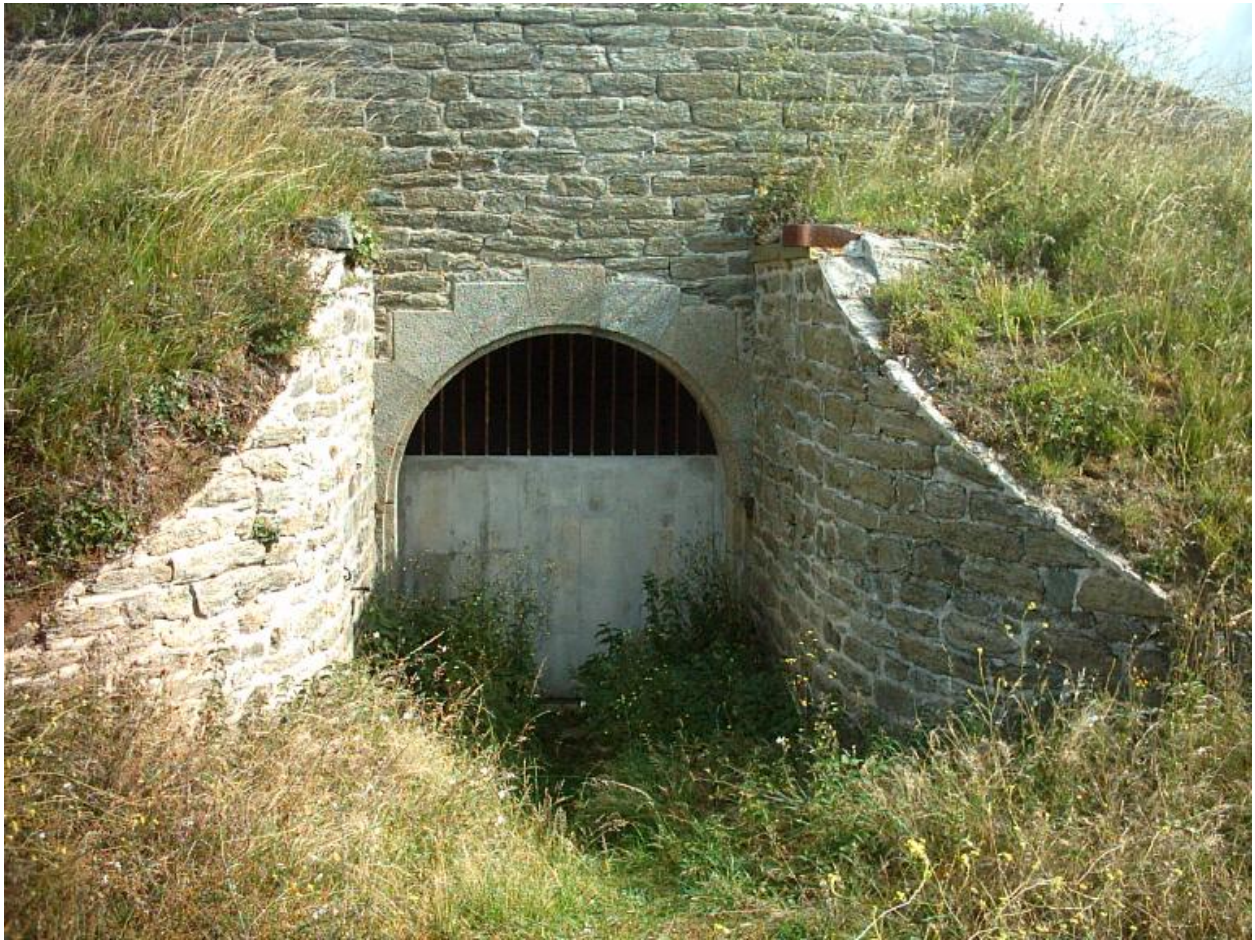
Groix, batterie du Bas-Grognon, débouché du monte-charge du magasin à poudre souterrain en 2007.
