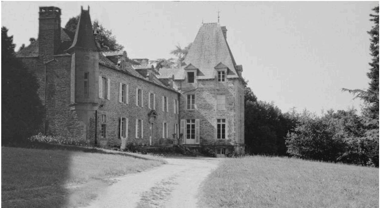
Château : élévation ouest (état en 1969)
