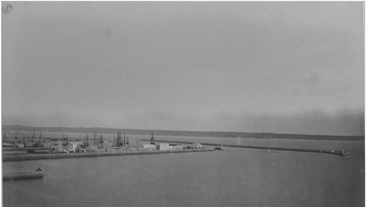
Vue de la jetée ouest et digue sud (J. Duclos, 1873)
