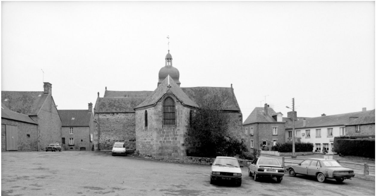
Elévation Est : vue générale
