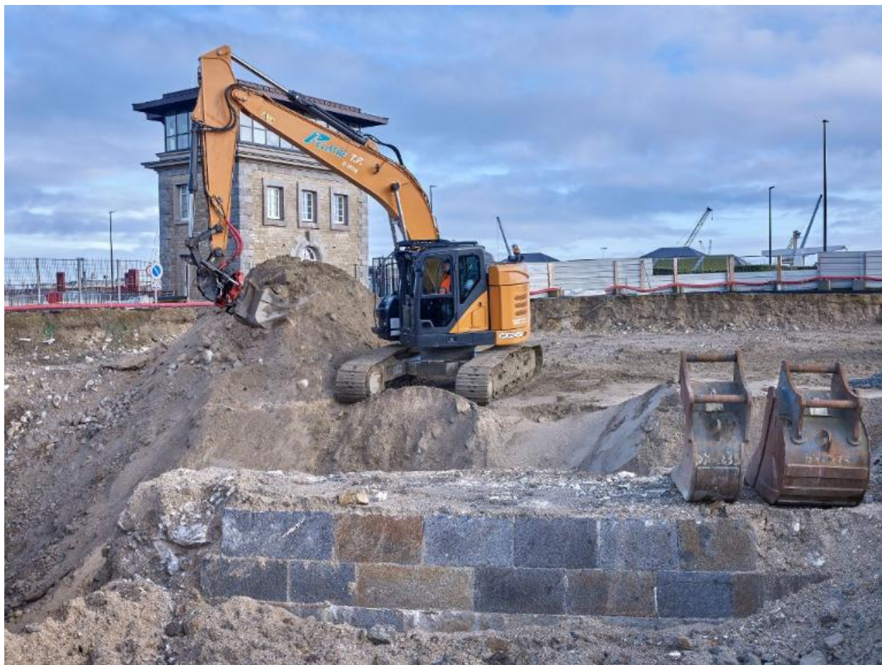
Vue des vestiges du quai de l'avant-port de Saint-Servan : élévation sud-ouest, maçonnerie en pierre de taille de granite (couverture photographique du 22 janvier 2026). En arrière-plan, le poste de commande de l'écluse du Naye
