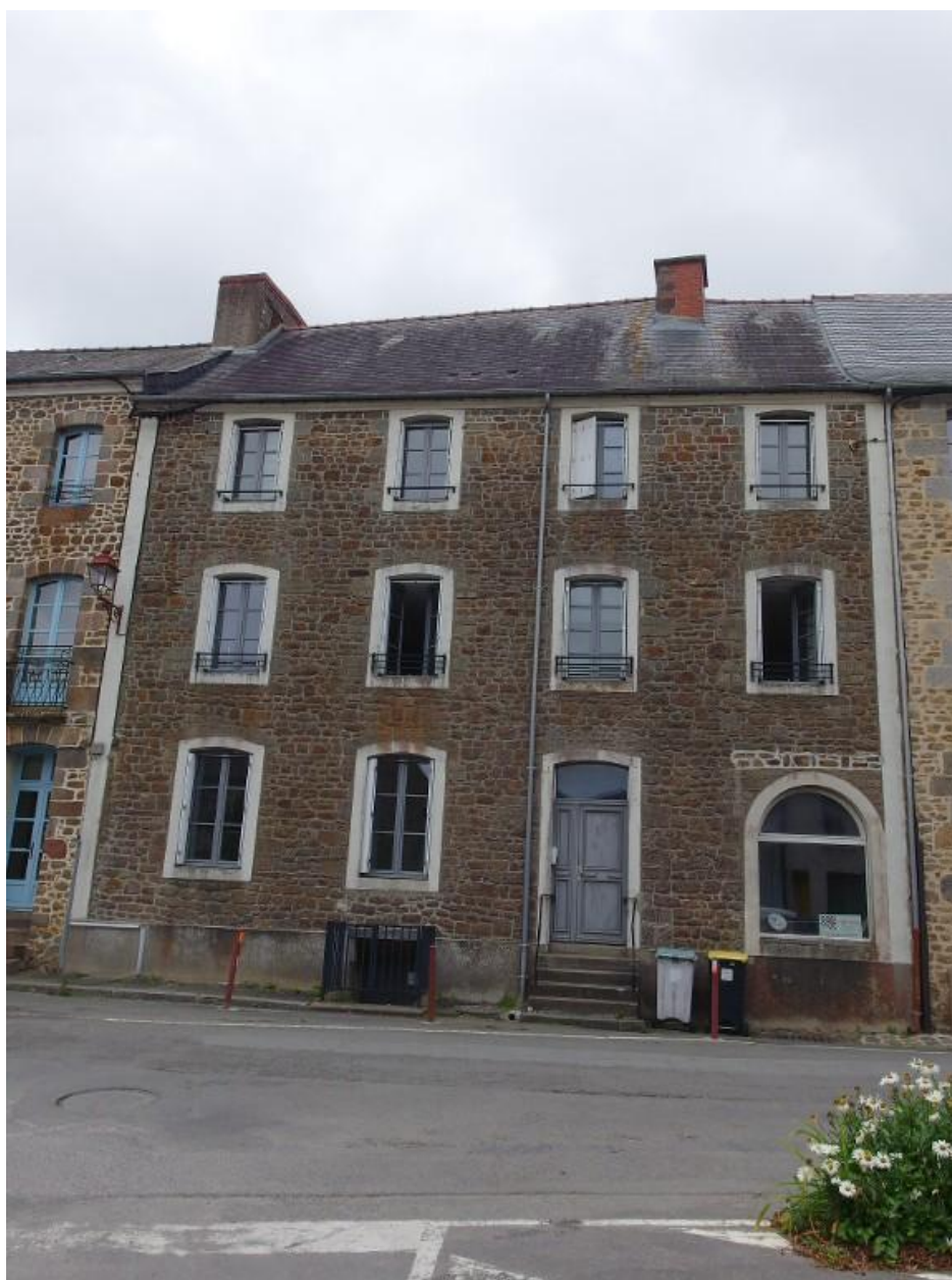
Vue de la façade ouest
