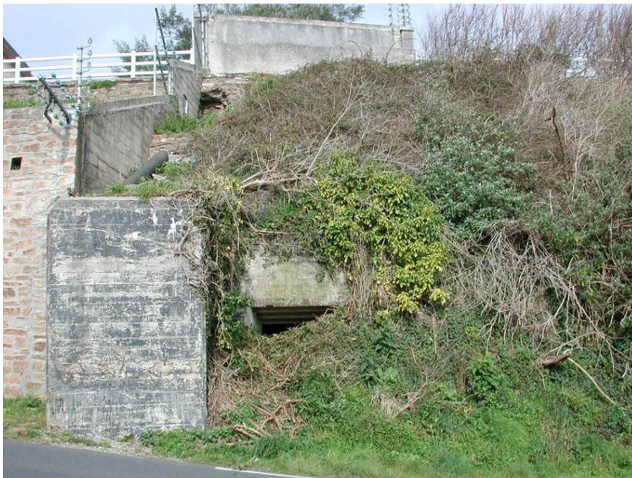
Vue de la casemate de type 667 SK des Quatre-Pompes : embrasure
