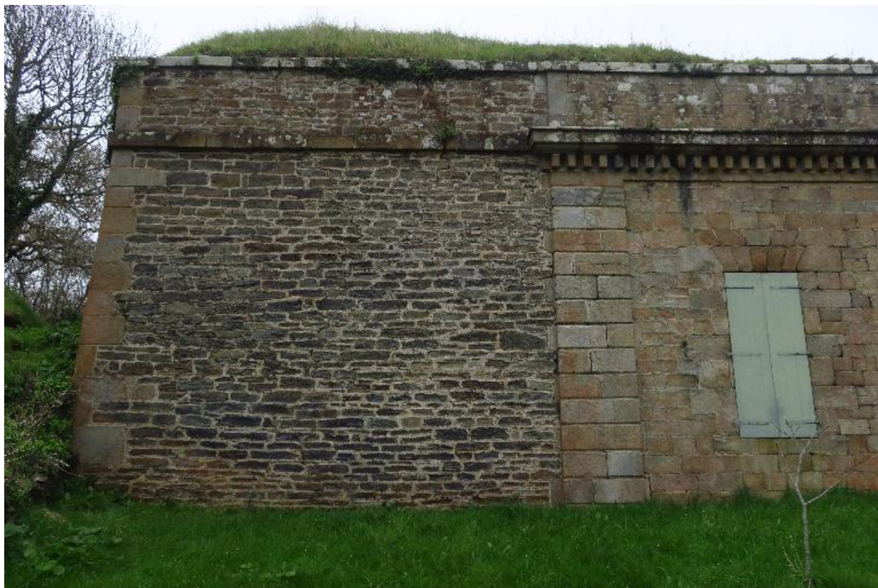
Le Palais, enceinte urbaine, réduit B, façade de gorge, détail.
