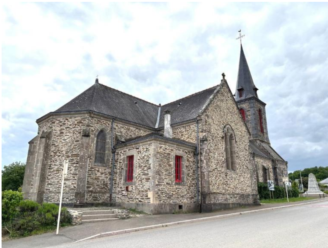
Vue nord-est de l'édifice.
