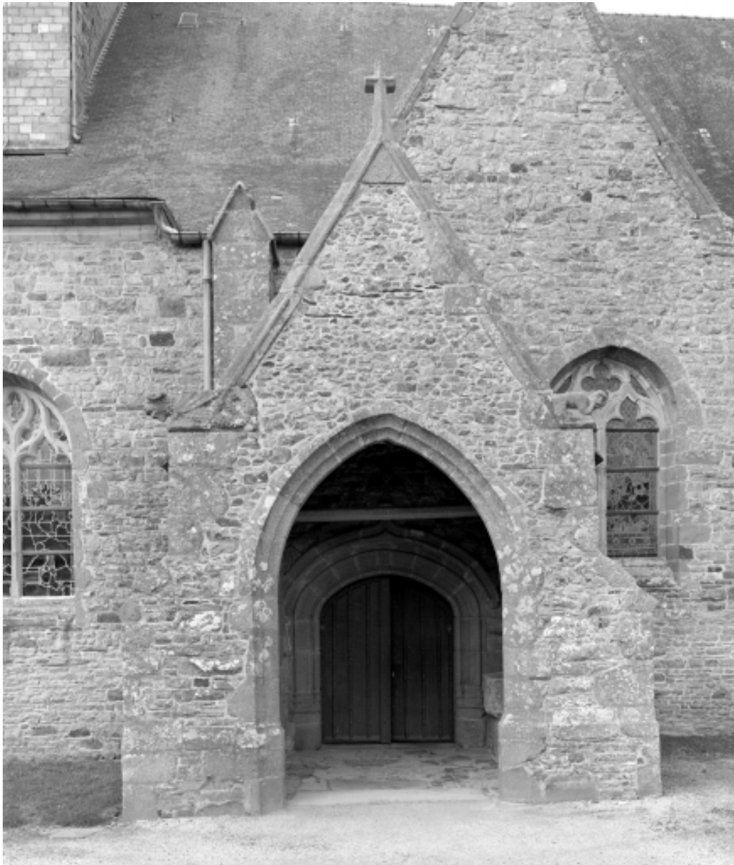
Elévation sud, détail du porche.
