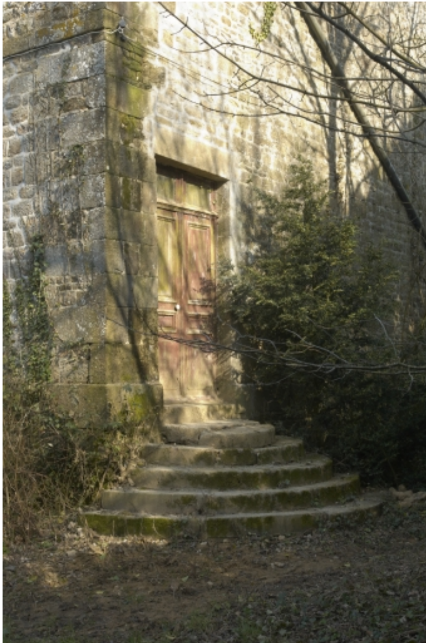
Porte d'entrée au pignon
