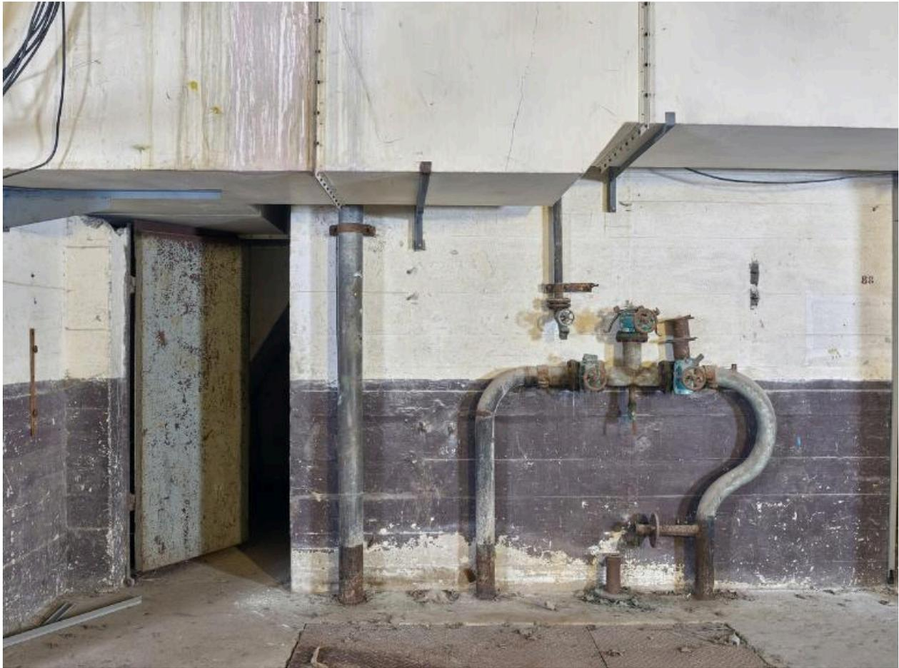
Locaux techniques, partie nord, rez-de-chaussée, grande pièce de la centrale électrique : porte de la cage d'escalier et tuyaux d'arrivée d'eau et vannes pour le refroidissement des moteurs. Des plaques précisent Eau de ville ou Eau de mer
