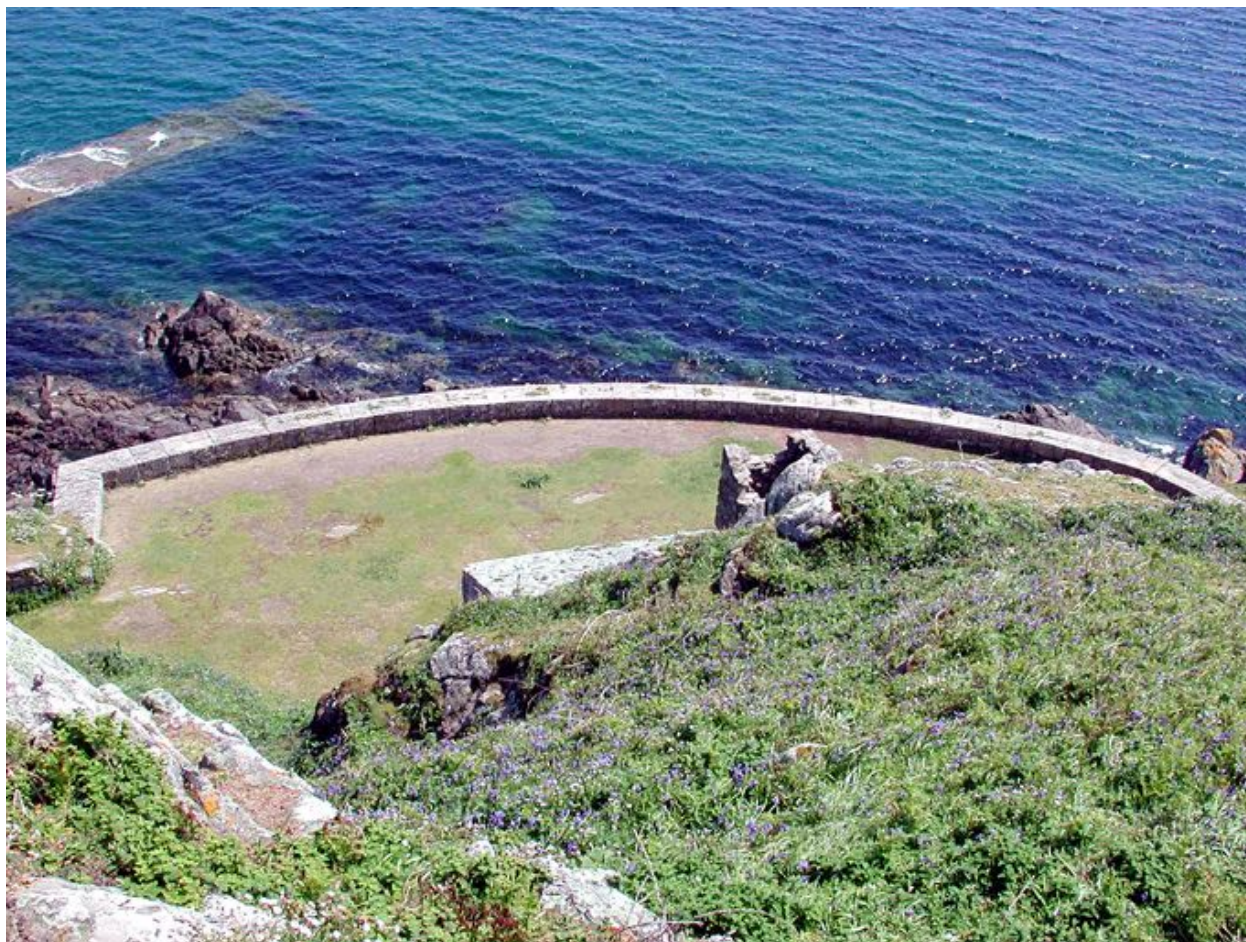
Vue générale depuis une position dominante (état en 2002)
