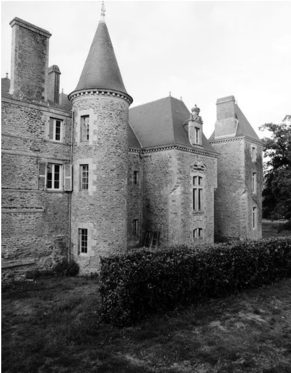
Elévation nord : vue générale prise du nord-est
