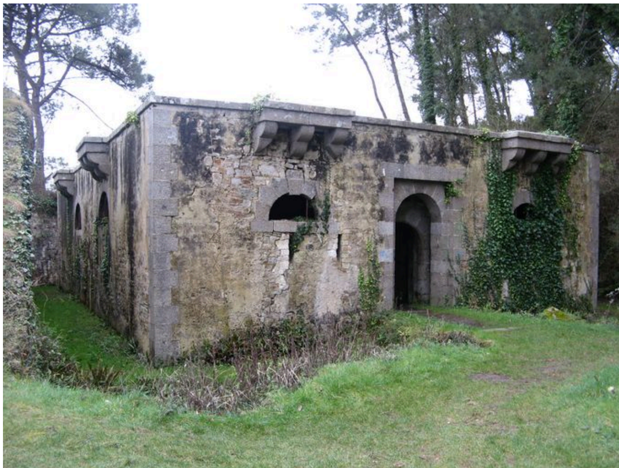
Réduit de type n°2 de la batterie basse du Kador
