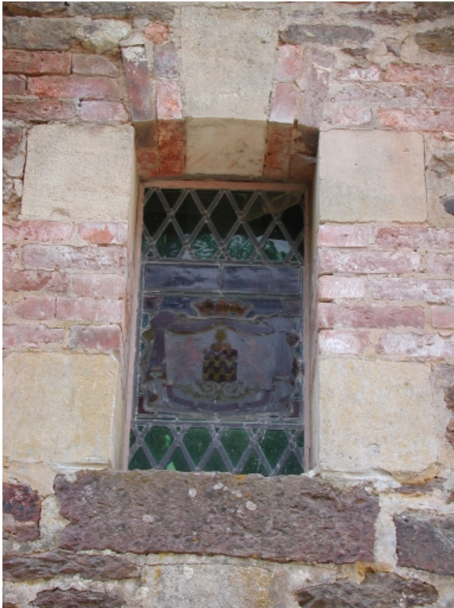
Ancienne chapelle ; détail, verrière avec armoiries
