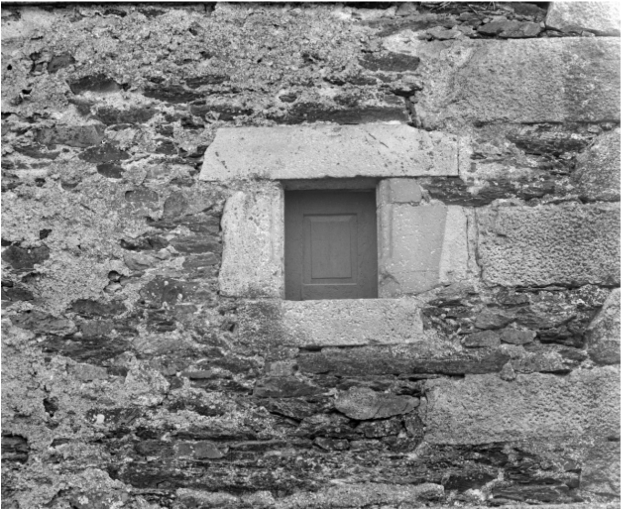
Elévation ouest, fenêtre ; vue générale
