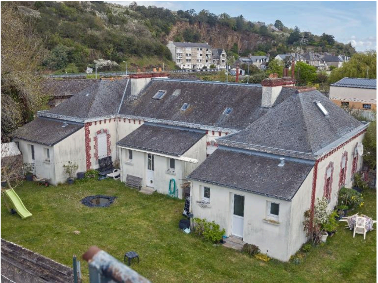
Elévation ouest de la maison des éclusiers
