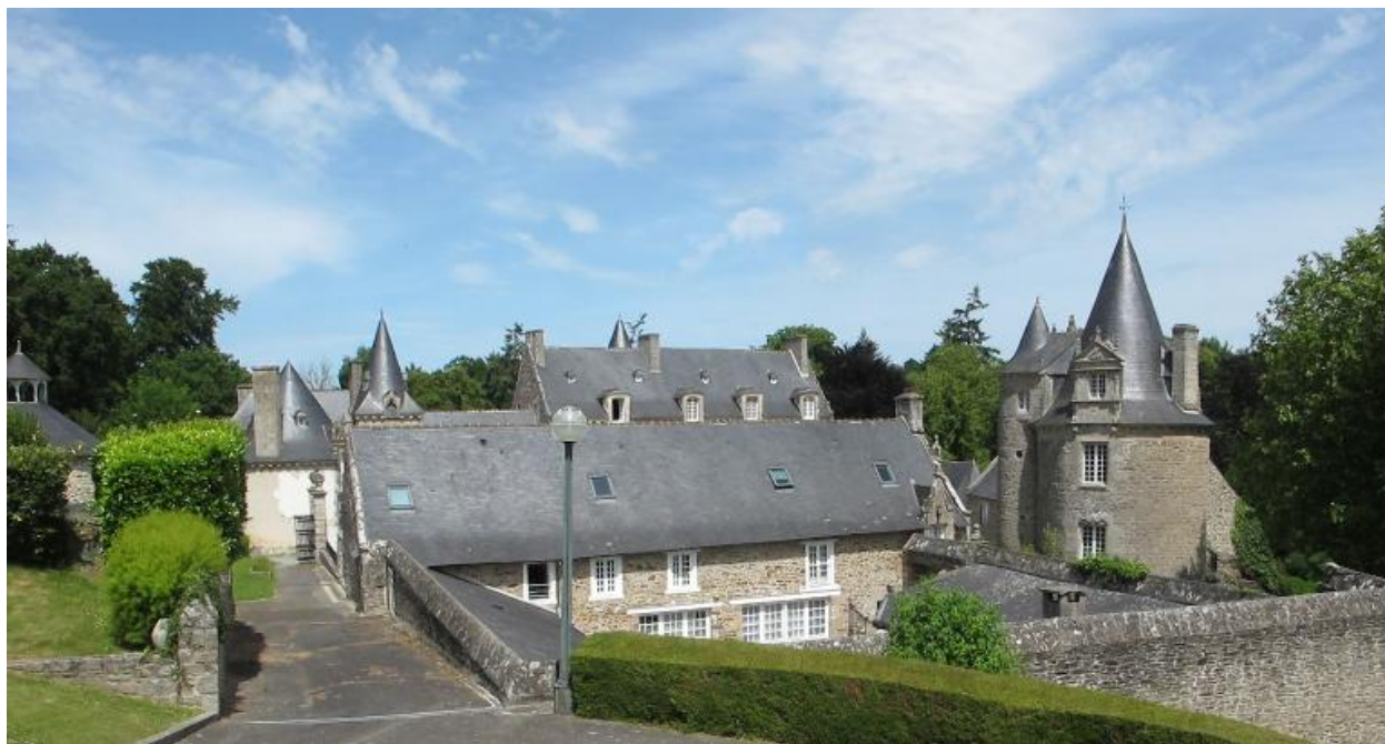
Vue des toitures, prise du sud-ouest
