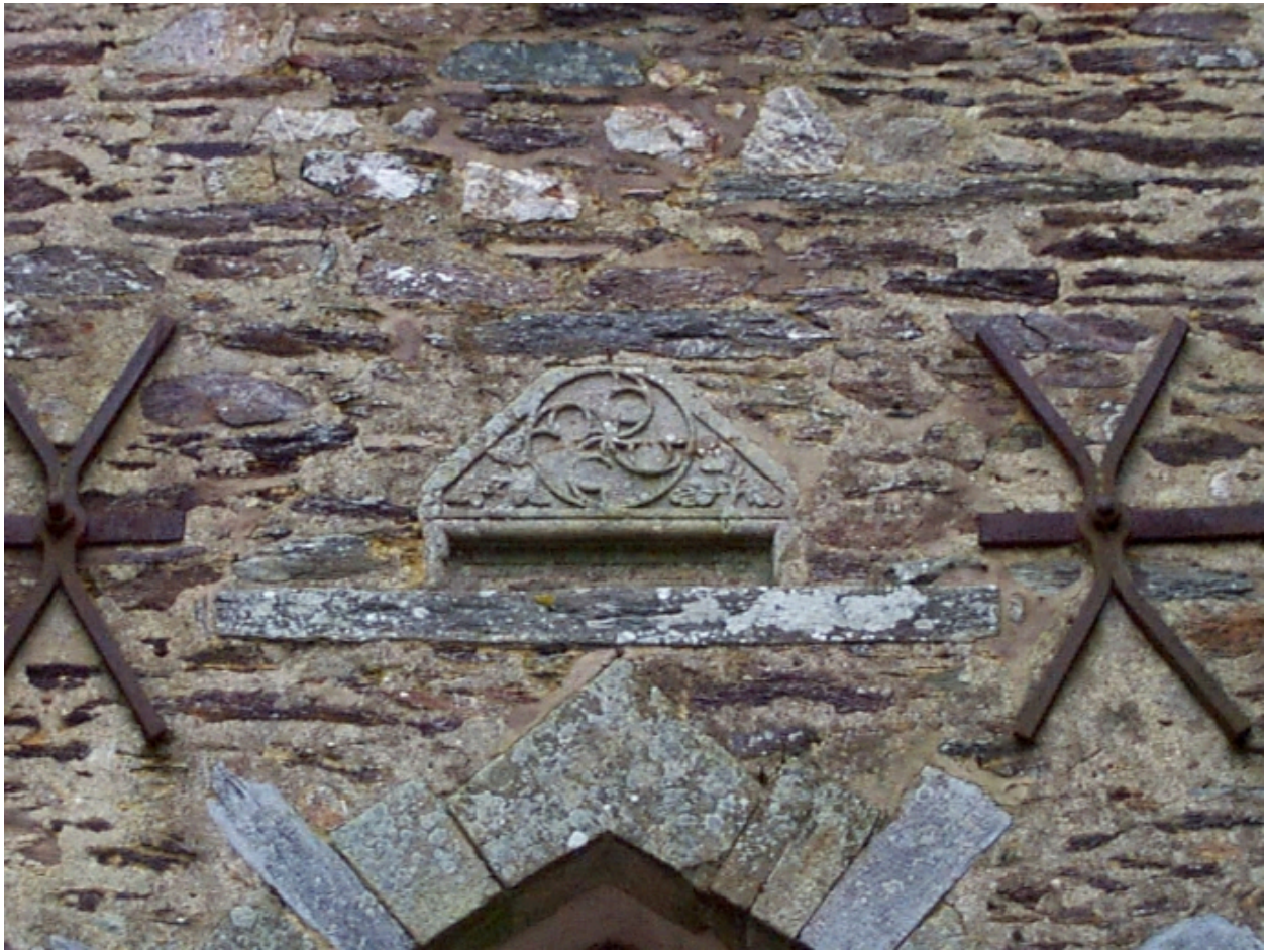
Pierre de rempli au dessus du portail : détail
