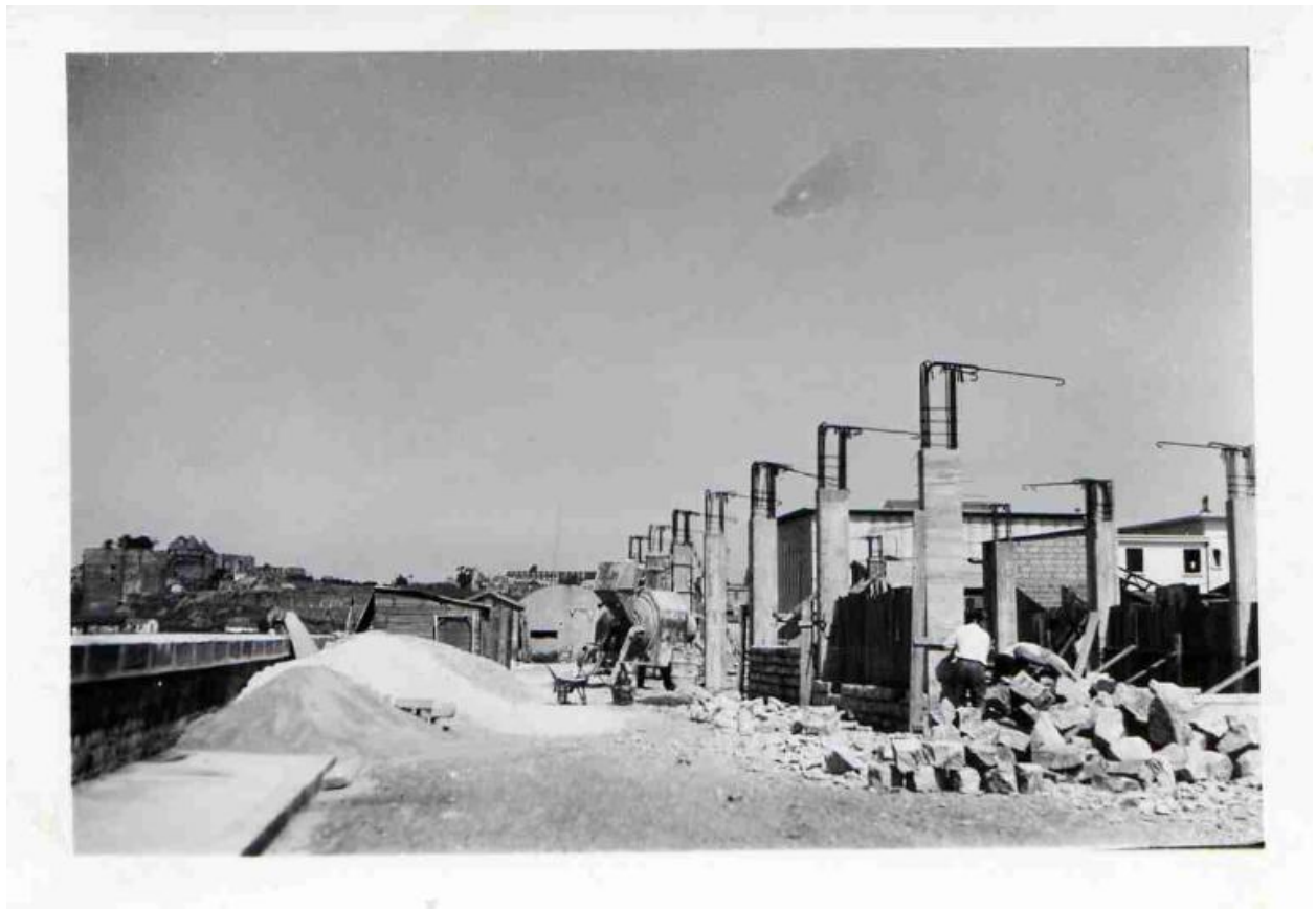
Magasins annexes du Parc en cours de construction (07/06/1949)
