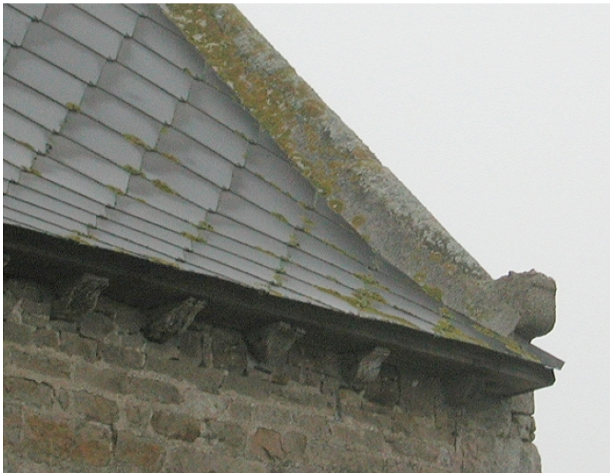
Vue détaillée du rampant et de la corniche.
